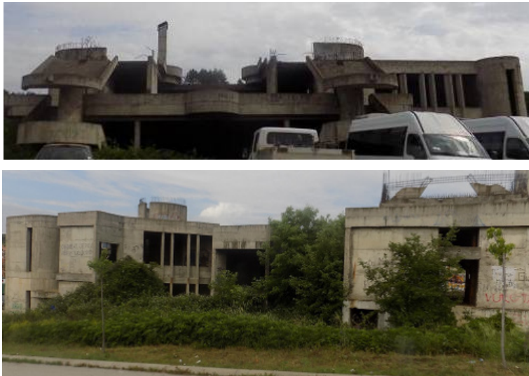
Foto 1. Izgled objekta (Dom kulture u Kuršumliji)
