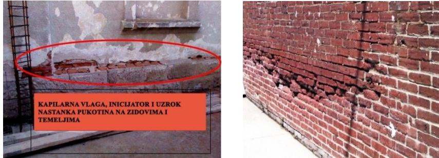
Slika 4. Nastanak oštećenja zidova usled kapilarnog penjanja vode
