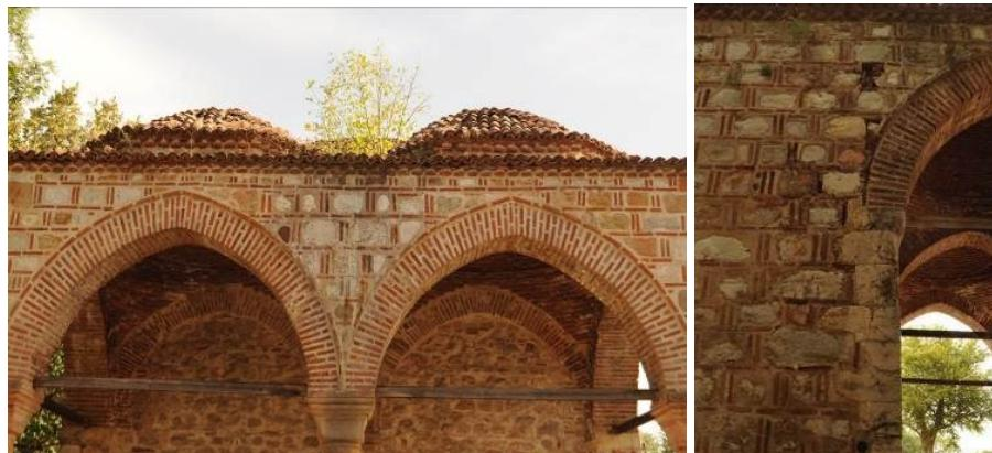
Slika 4. Divlje rastinje na krovu trema (levo), i oštećenja nastala od vlage (desno) . Foto A.Mirić, sept.2017
