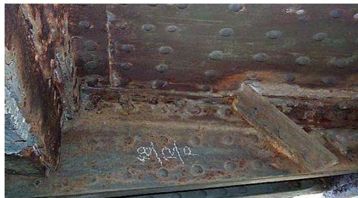
Slika 16.-Korozija čeličnog nosača
