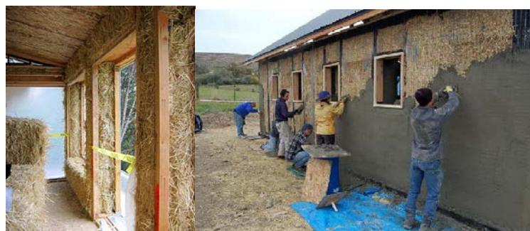
*Slika 6. - Ugradnja i završna obrada zidova od slame*
