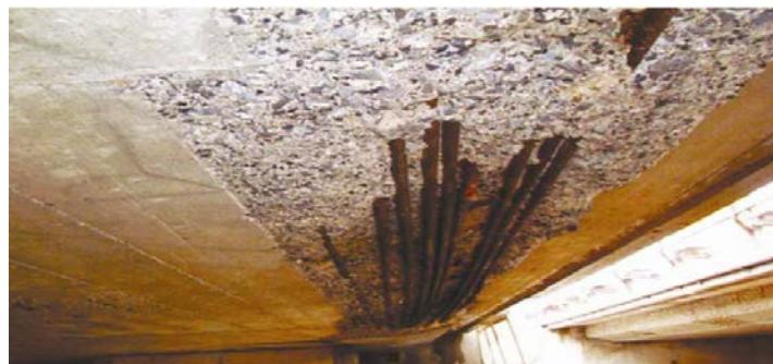
Slika 15.-Korozija armature
