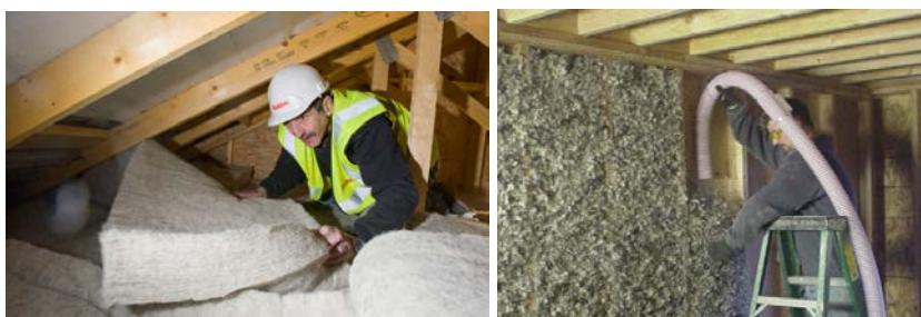
Slika 1.- Ugrađivanje gotovih vunenih panela i ugrađivanje ventilatorom
