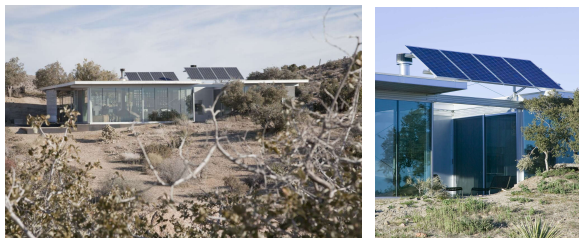
Slika 11 – Prikaz fotonaponskog panela instaliranih na ravnom krovu montažne kuće u Kaliforniji
