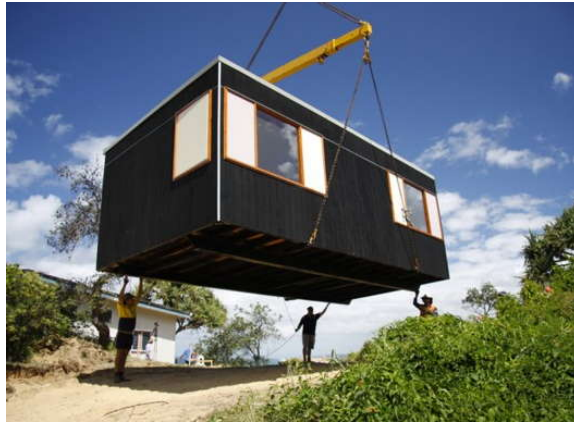
Slika 5 – Montaža ćelijskih jedinica na predviđenoj lokaciji
