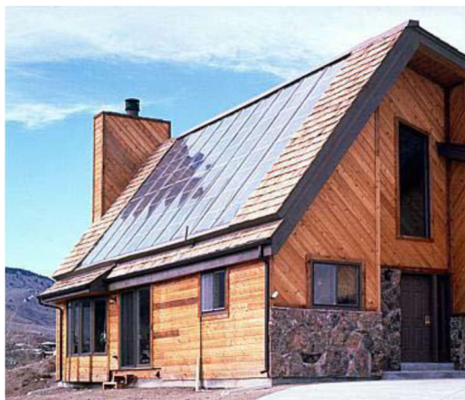
Slika 7 – Izgled fotonaponskog panela integrisanog u krovnu konstrukciju
