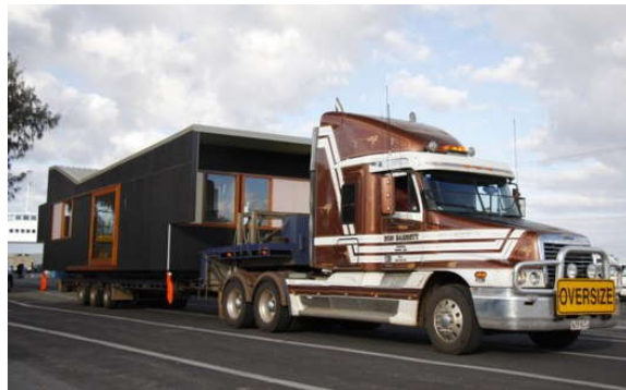
Slika 4 – Transport gotove ćelijske jedinice do mesta montaže
