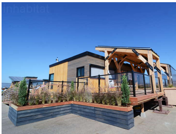
Slika 10 – Prikaz fotonaponskog panela instaliranih na krovu montažne kuće
