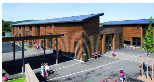
Slika 8 – Prikaz fotonaponskog panela instaliranih na krovu osnovne škole
