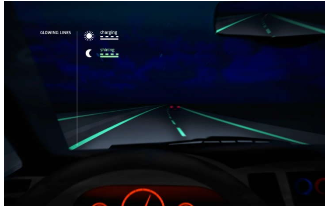
Slika 1. Svetleće saobraćajne trake
