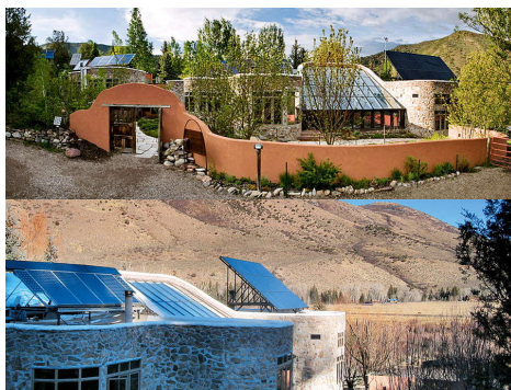
Slika 9 – Prikaz fotonaponskog panela instaliranih na krovu porodične kuće
