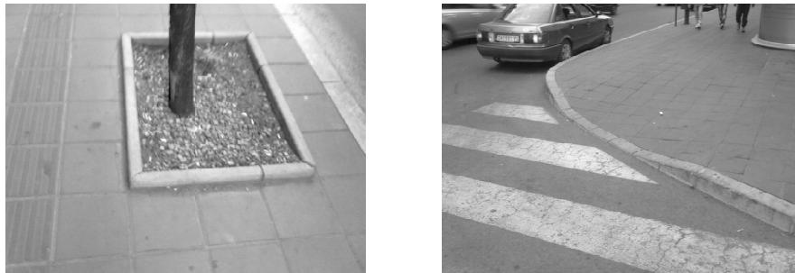
*Slika 5. Zastor od prefabrikovanih betonskih elemenata na pešačkoj stazi u ul. Vožda Karadordža*
