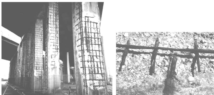
Slika 4. Primer korozije armature kod betonskog mosta
