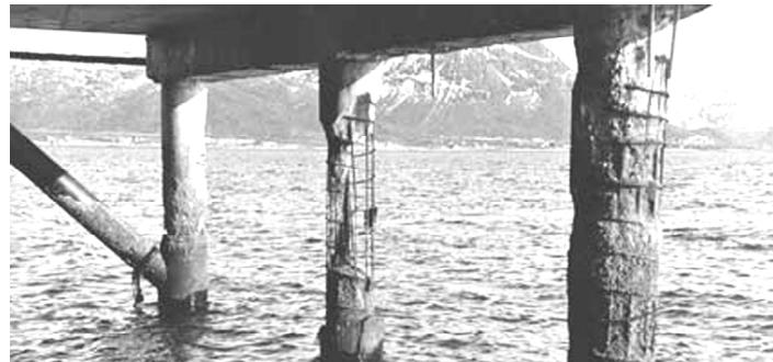
Slika 3. Primer superpozicije više oblika korozije betona u morskoj vodi
