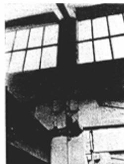
Slika 6 - Oštećenje na dilatacionoj razdelnici (Skoplje, 26.07.1963.)
