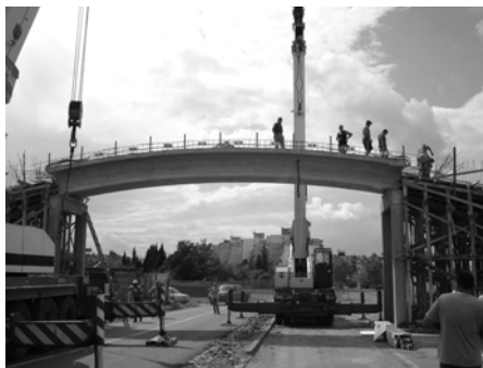
Slika 14. Greda neposredno pred konačno postavljanje Slika 15. Greda postavljena na AB ramove
