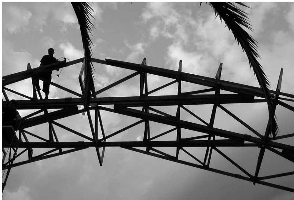
Slika 6. Montaža prototipa cilindrične naboraste konstrukcije
