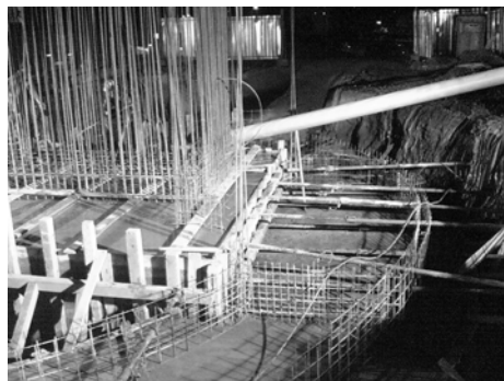
Slika 5. Dio temelja poslije betoniranja
