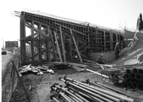
Slika 11. Južni dio, vidi se skela i dio rampe
