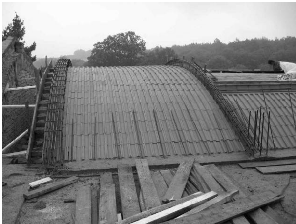
Slika 12 - Opečna oplata svodova
