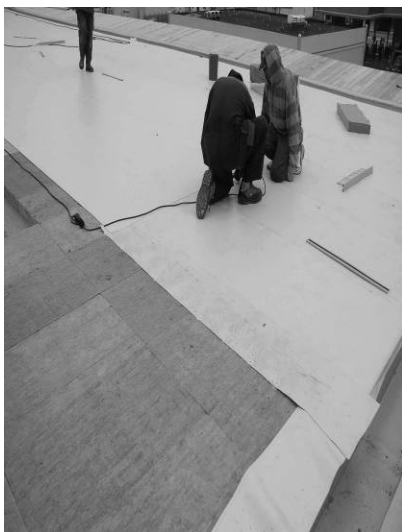
Slika 12 Postavljanje izolacije krova
