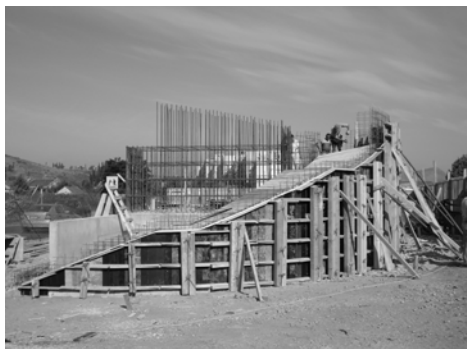
Slika 7. Šalovanje polukružnih zidova i rampe
