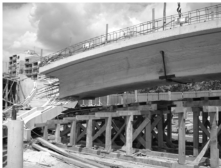
Slika 12. Greda u trenutku odizanja sa skele
