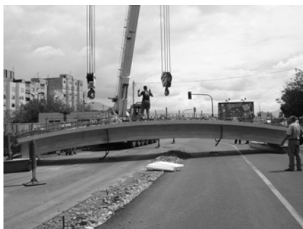
Slika 13. Jedna od faza prenosa grede
