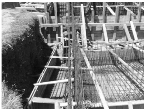
Slika 4. Dio temelja prije betoniranja
