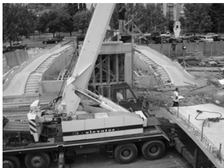
Slika 14. Greda neposredno pred konačno postavljanje Slika 15. Greda postavljena na AB ramove
