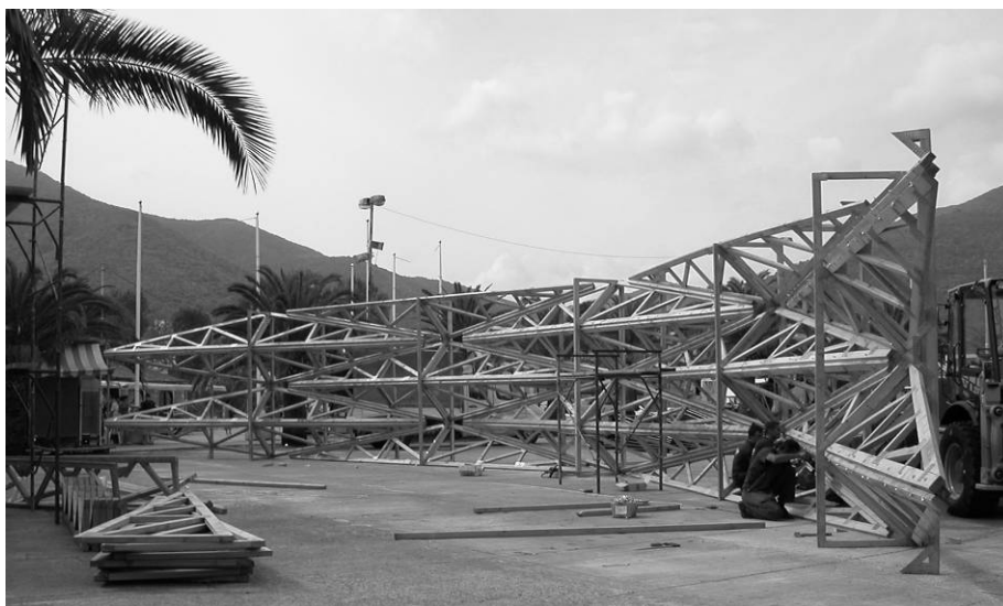
Slika 1. Montaža konstrukcije na tlu
