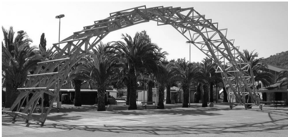
Slika 5. Montirani prototip cilindrične naboraste konstrukcije na sajmu
