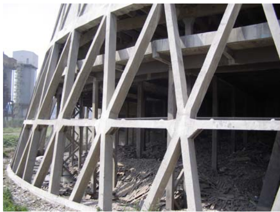
Slika 2 – (a) Rashladni toranj 2 TE Tuzla; (b) Oslonački stubovi rashladnog tornja 4 TE Tuzla
