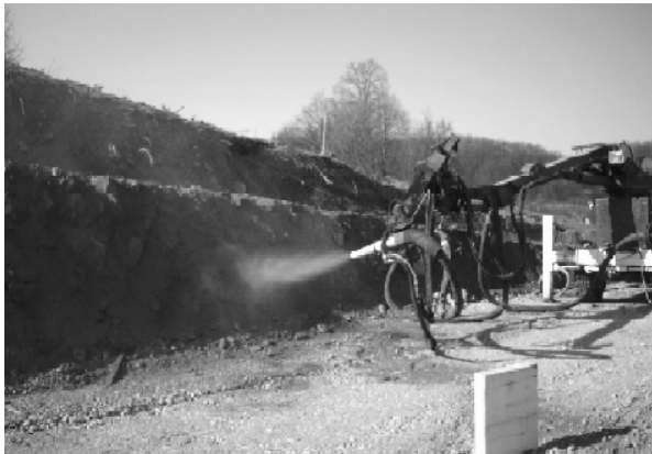
Slika 3. Torkretiranje robotom tunela Klačnice-Banja Luka (opitno polje)
