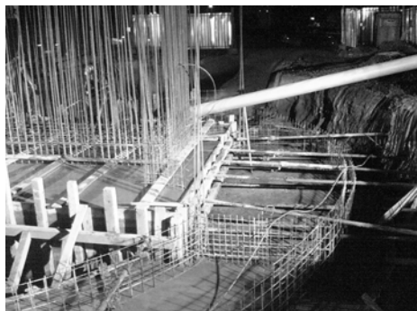
Slika 9. Pogled na dio skele montažne grede
