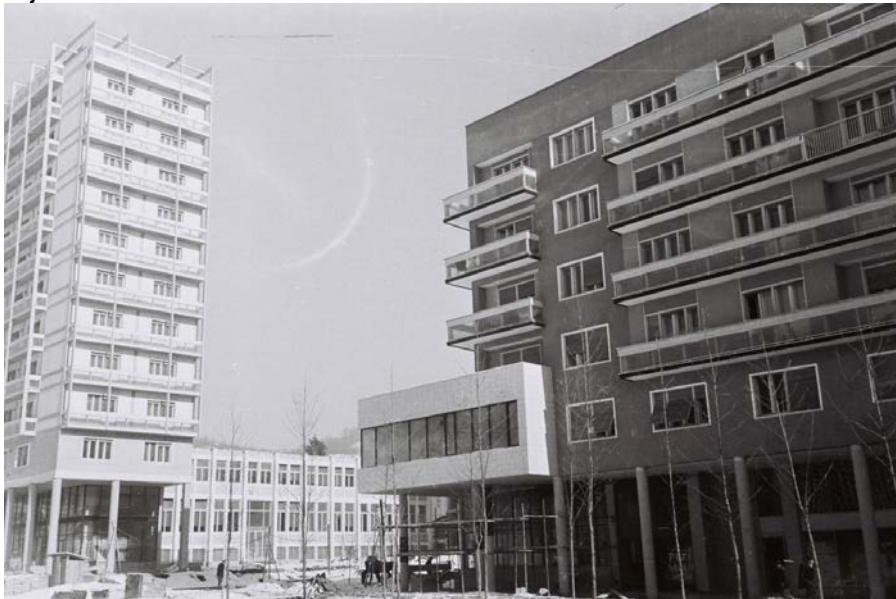
Slika 06. Gradska kafana tokom izgradnje (1961)
