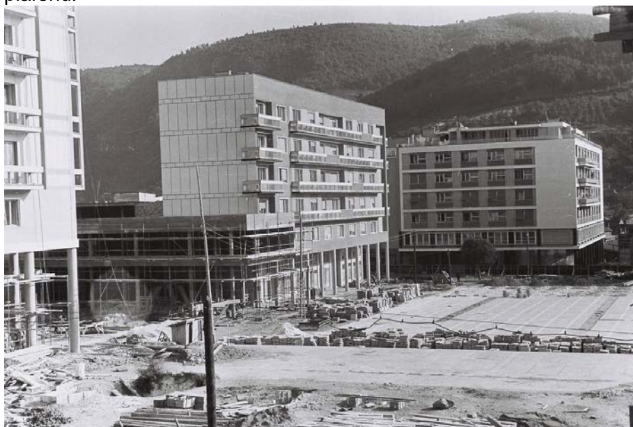
Slika 05. Gradska kafana tokom izgradnje (1960)
